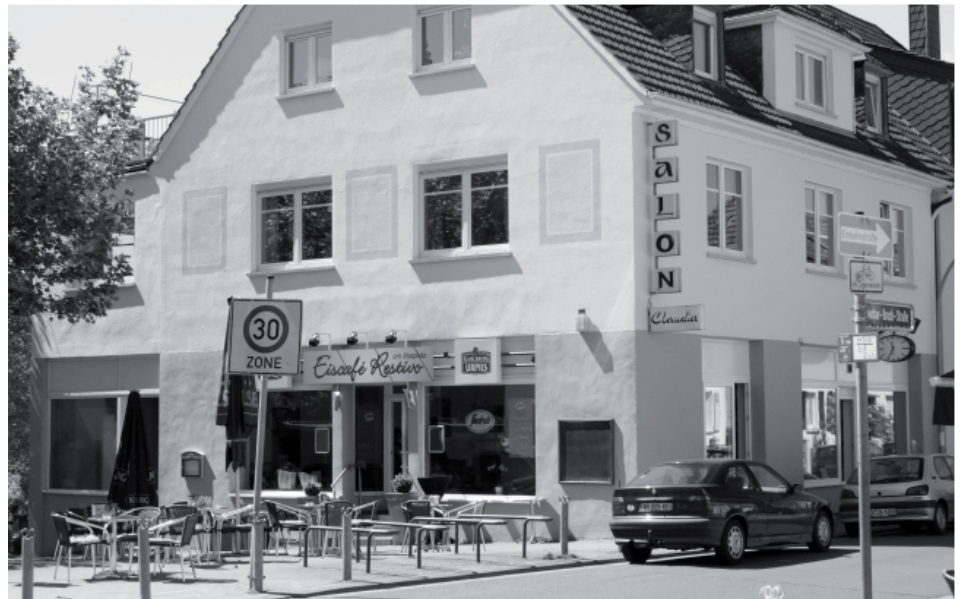
Eckhaus Gustav-Bruch-Straße / Riotte Straße
